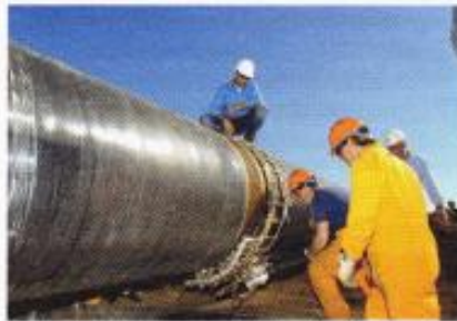
Evoluzione naturale L'assemblaggio di una pipeline per il gas
